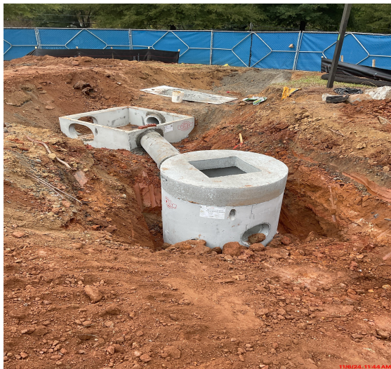
Storm Pipe E2 installed
